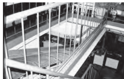
図20 倉庫時代からのベルトコンベア 美術館では時折、実用にも使われた。
