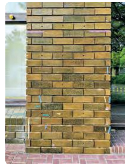
カラフルなマスキングテープが楽し気ですが、改修に向けた事前調査の様子です。タイルの浮きやひび割れなど症状の度合を色ごとにランク付けて示しています。
